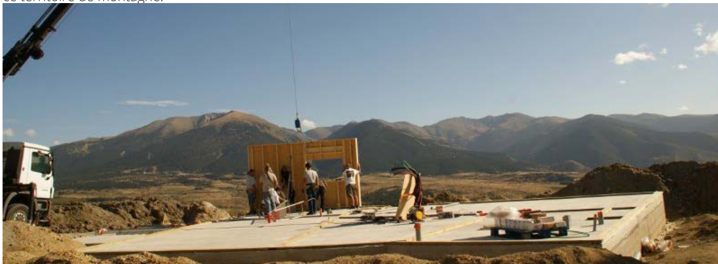
Construction de chalet à Font-Romeu
