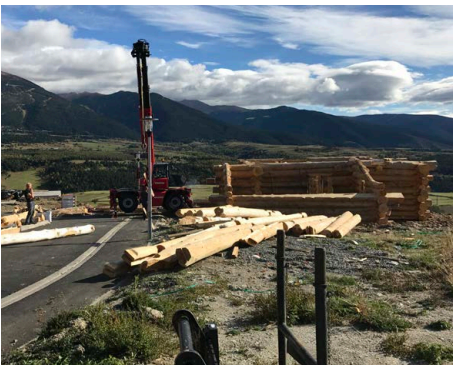
Construction de chalets individuels à Bolquère - Lotissement Les Fermes 1650
