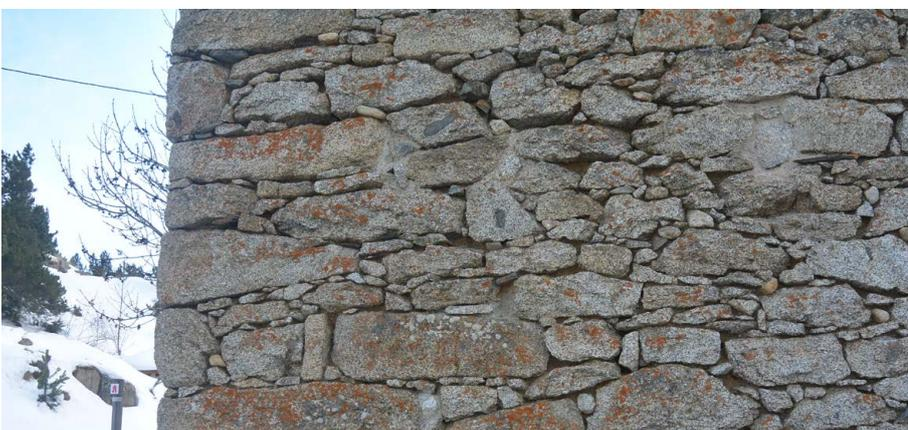
Mise en œuvre traditionnelle d'un mur en moellons - bloqués par des cailloux - sans hourdage
