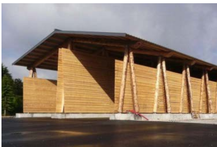
Hangar de stockage
